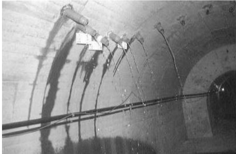
Gambar : keadaan didalam terowongan drainase
